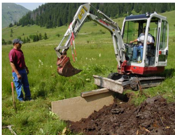
Mise en place des panneaux dans la tourbe
